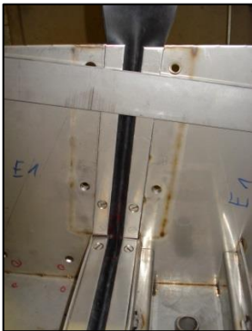
Rinne mit Dilafuge
