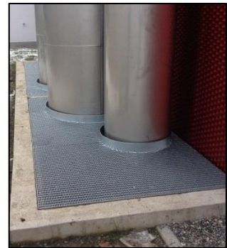
Gitterrost um Lüftung
